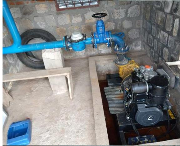
Motopompe diesel de la station de pompage d'eau potable de Gitara qui a été remplacé par le pompage à l'énergie solaire photovoltaïque
