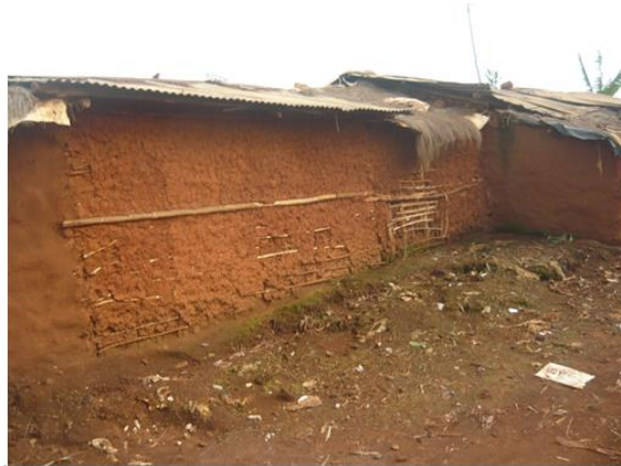
Photo 3 : maisonnettes avec ossature de perches et remplissage de terre, camp Kinama
