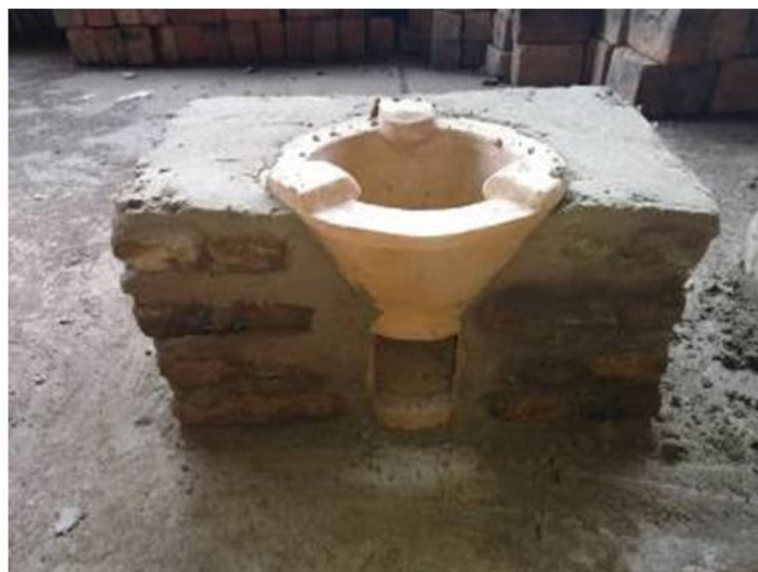
Photo 14 : Foyer amélioré encastré dans une maçonnerie en briques cuites pour améliorer sa durabilité et maniabilité
