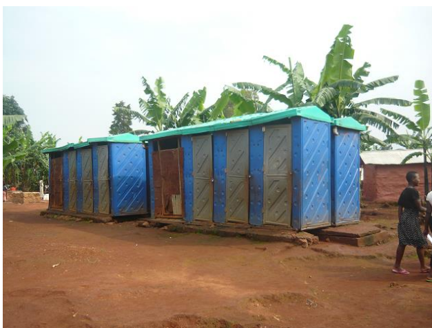
Photo 5 : Blocs de latrines à 8 portes avec fosse vidangeable, camp Musasa
